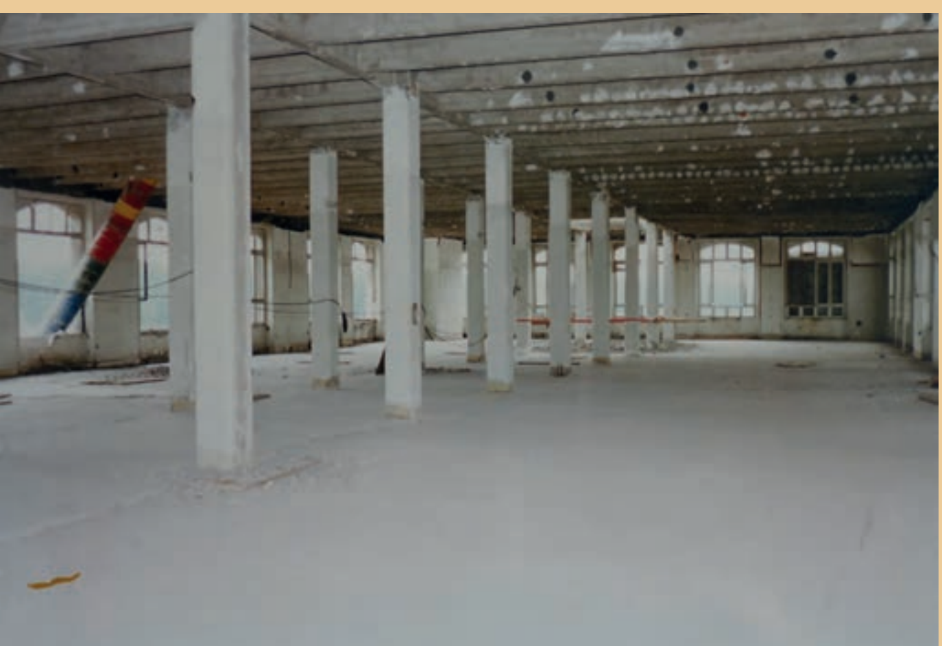
Travaux de rénovation, 1992
